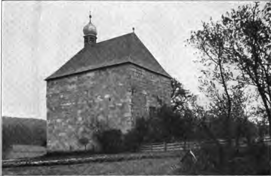
Fig. 122. Schönfeld. Nordwestansicht der Kirche.
